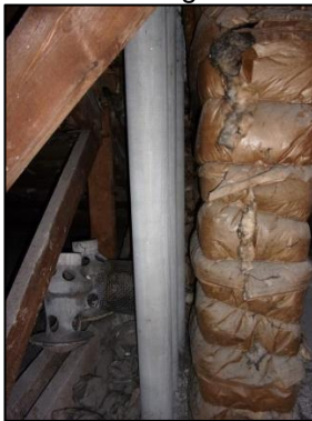
Photo N° 1999 AMIANTE CIMENT -- Comble Gains verticaux Ventilation haute (Fibres-ciment)
