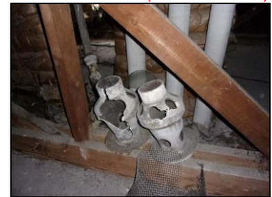
Photo N° 1997 ECH-N°003 AMIANTE CIMENT --Boxes Toiture Toiture ondulée (Fibres-ciment)
