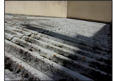
Photo N° 1997 ECH-N°003 AMIANTE CIMENT --Boxes Toiture Toiture ondulée (Fibres-ciment)
