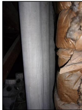
Photo N° 2000 AMIANTE CIMENT -- Comble Gains verticaux Ventilation haute (Fibres-ciment)
