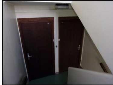
Photo N° 1992 ECH-N°002 – Palier 1 er Murs Peinture + enduit
