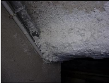
Photo N° 1984 ECH-N°001 FLOPAGE --Couloir cave Plafonds Flocage
